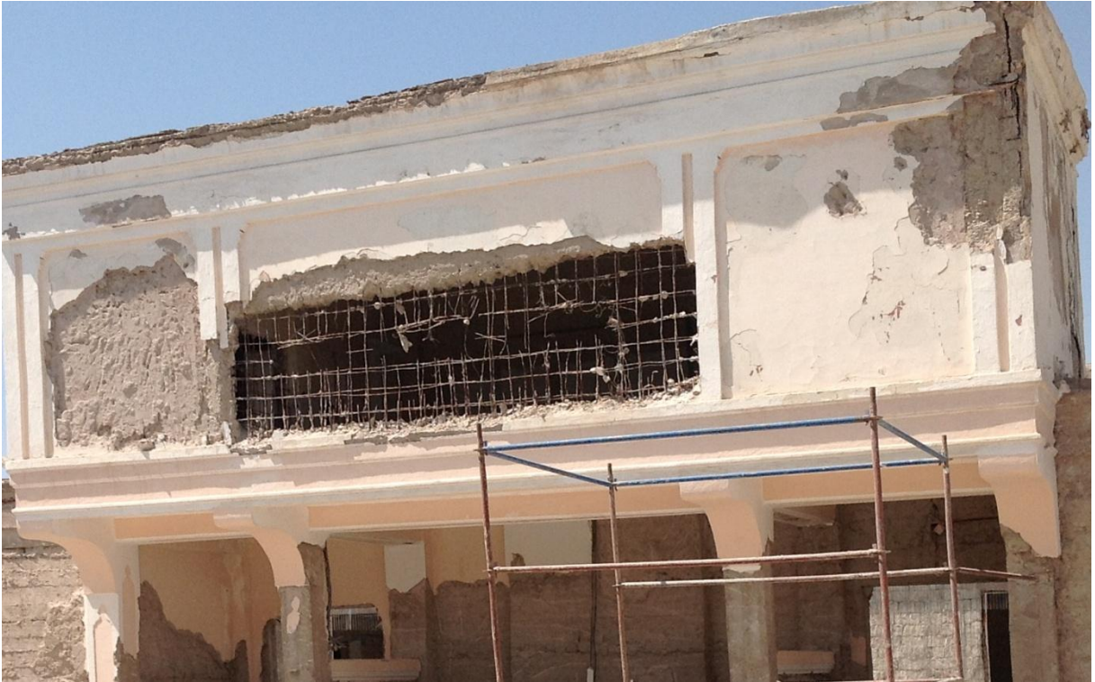
Tasarım hatası (Perdenin altında zayıf kolonlar tasarlanmış)
