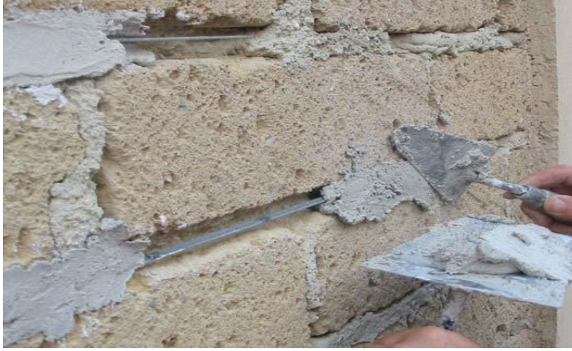
Şekil 29. Mbar® kullanılarak duvarların güçlendirilmesi
