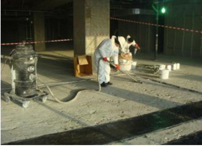
Şekil 5. Döşeme negatif moment bölgesinde yapılan uygulama için yüzey temizliği
