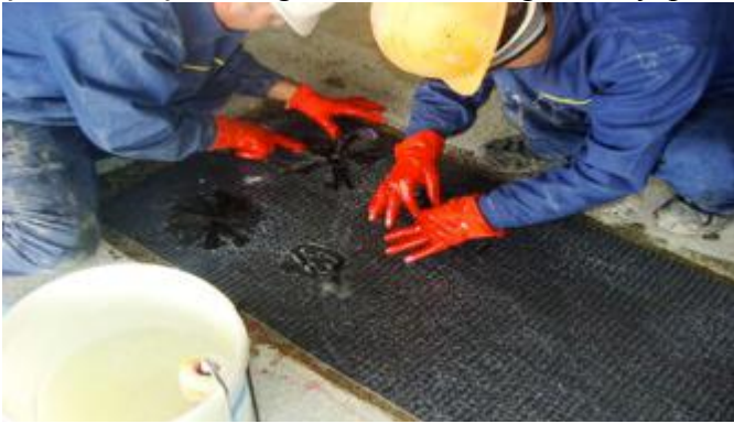
Şekil 6. Eğilmeye karşı yapılan LP uygulamasında ankrajların uç bölgede teşkili
