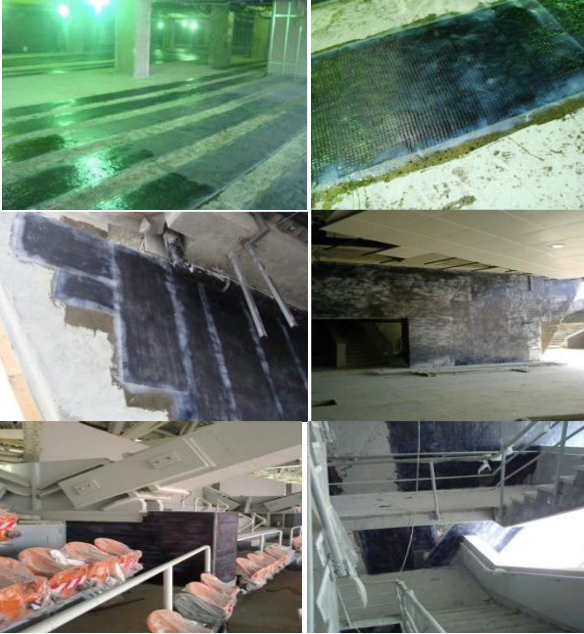
LP ile yapılan güçlendirmelerden örnekler: döşeme negatif moment bölgesinde uygulama (a) ve (b), taşıyıcı merdiven kovalarında perde etrafında güçlendirmeler
