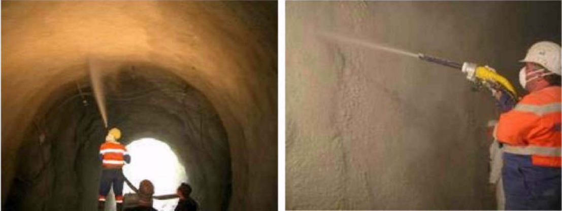
Şekil 7: MASTERSEAL®345 püskürtülmesi
